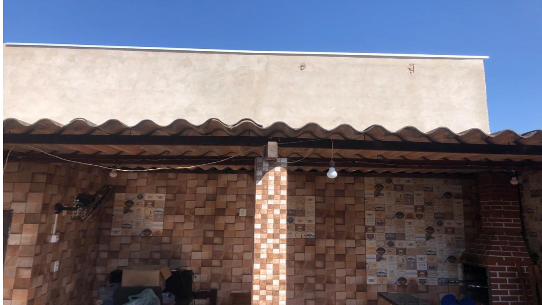
Figura 7. Telhado da análise da implementação na residência
