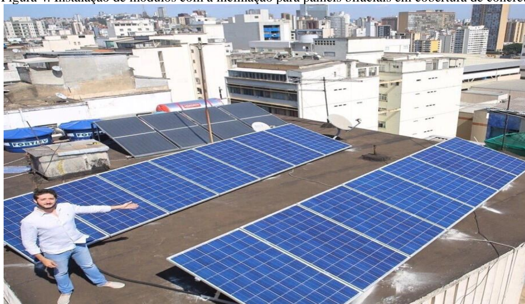
Figura 4. Instalação de módulos com a inclinação para painéis bifaciais em cobertura de concreto
