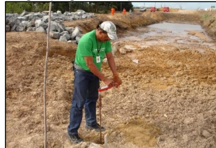
Figura 9. Preparação para execução do ensaio “vane-test”.
