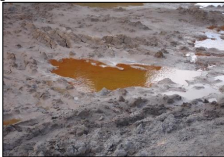
Figura 6. Existência de solo mole no trecho 1.
