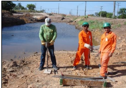
Figura 8. Execução de ensaio DPL.
