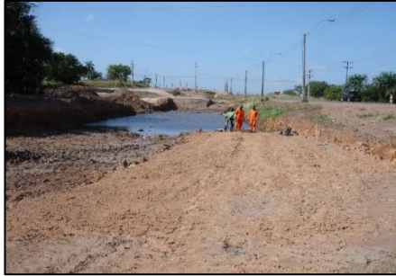
Figura 4. Vista do trecho 1 (Estacas 181 a 188).
