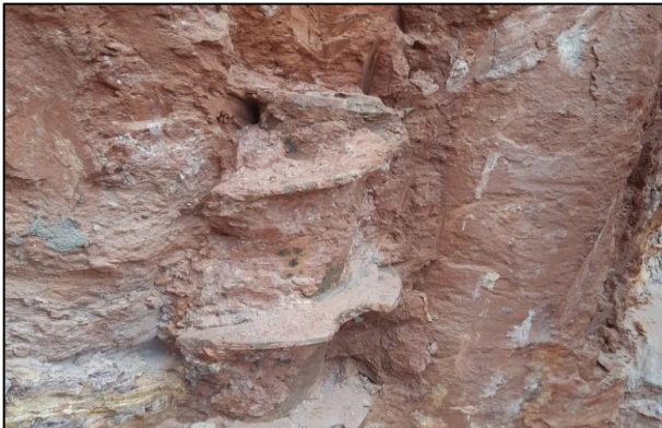
Figura 14. Broca da hélice contínua perdida durante a perfuração da estaca e encontrada na escavação do subsolo.
