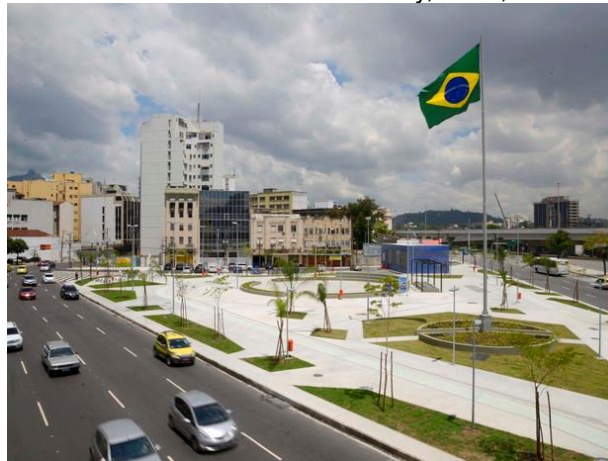
Figure 4: Praça da Bandeira Detention Reservoir - Ready, 2015, Rio de Janeiro - RJ - Adapted.
