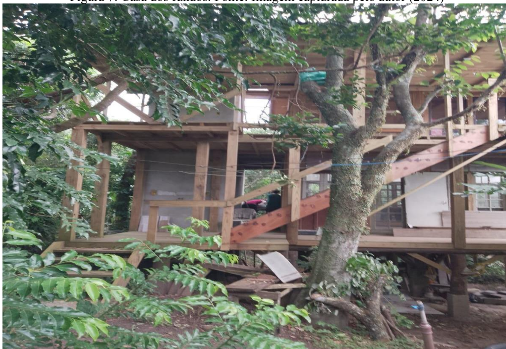
Figura 7: Casa dos fundos. Fonte: Imagem capturada pelo autor (2024)
