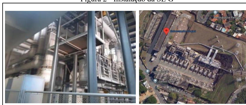
Figura 2 - Instalação da SE G
