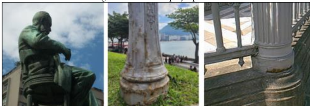
Figura 2 Corrosão em praças públicas
