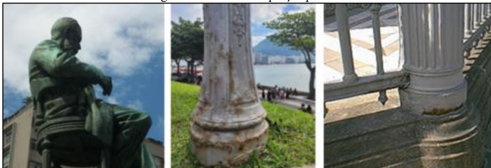
Figura 2 Corrosão em praças públicas
