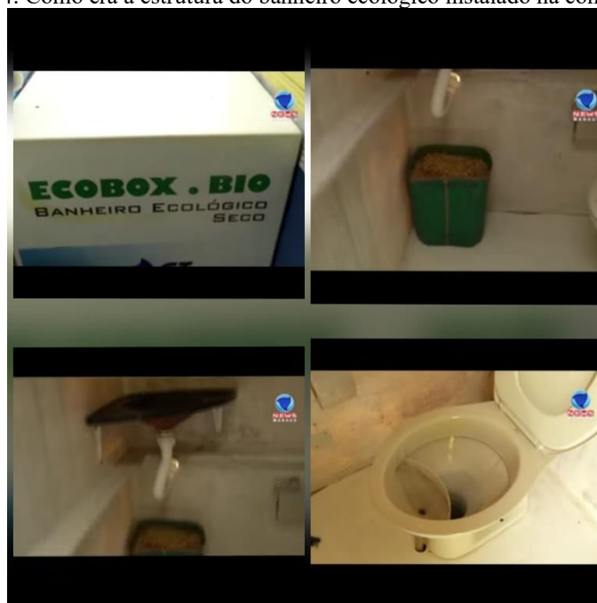
Figura 4: Como era a estrutura do banheiro ecológico instalado na comunidade
