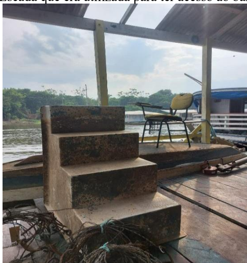
Figura 2: Escada que era utilizada para ter acesso ao banheiro seco
