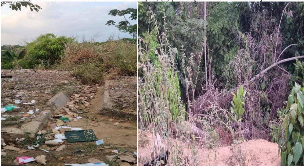
Figura 15: (a) sistema de canaletas sem manutenção; (b) presença de erosões no conjunto Colinas Park
