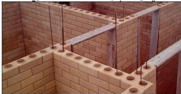
Figura 2 – Assentamento dos tijolos ecológicos
