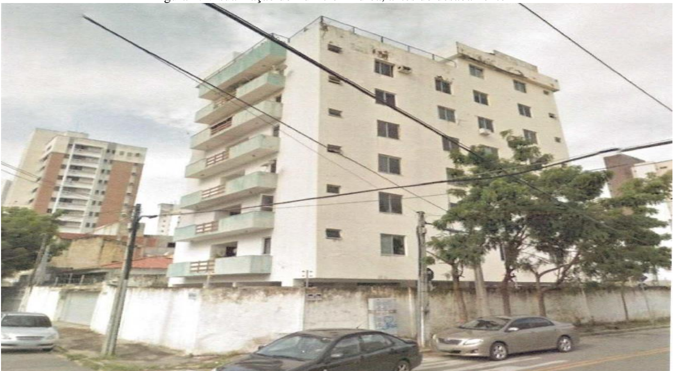
Figura 2: Visualização do Edifício Andréa, antes do desabamento
