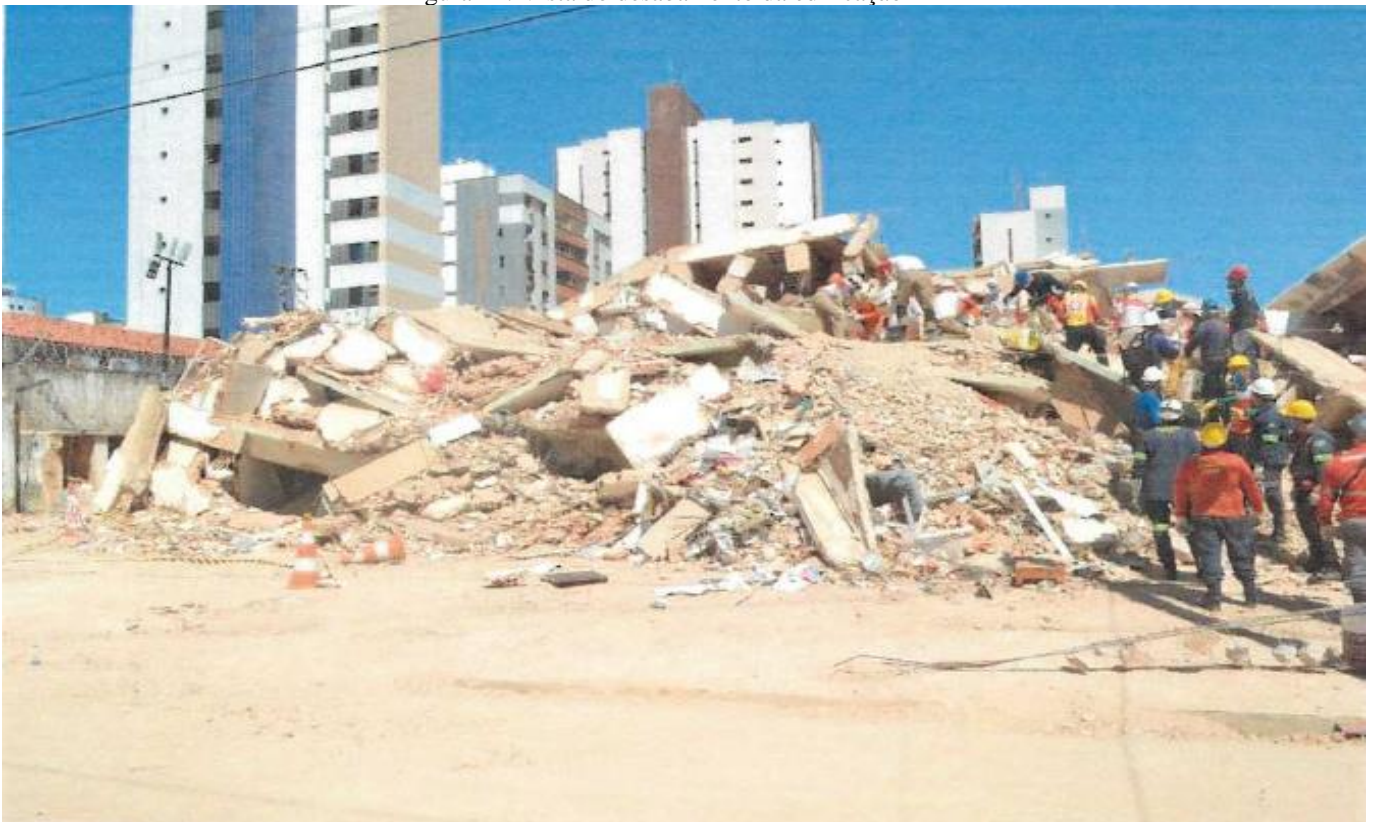
Figura 12: Vista do desabamento da edificação
