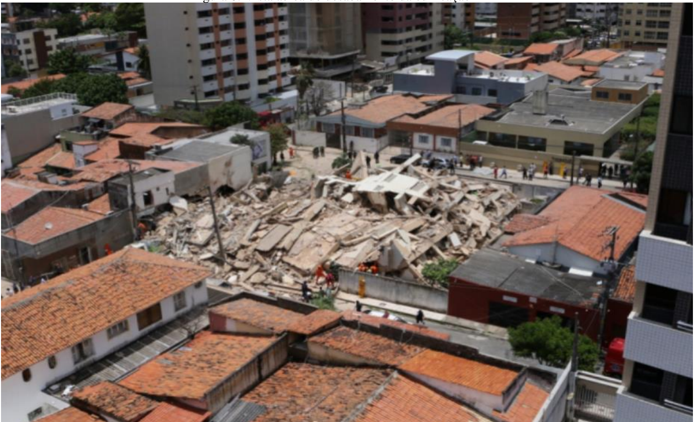
Figura 8: Vista aérea do desabamento da edificação
