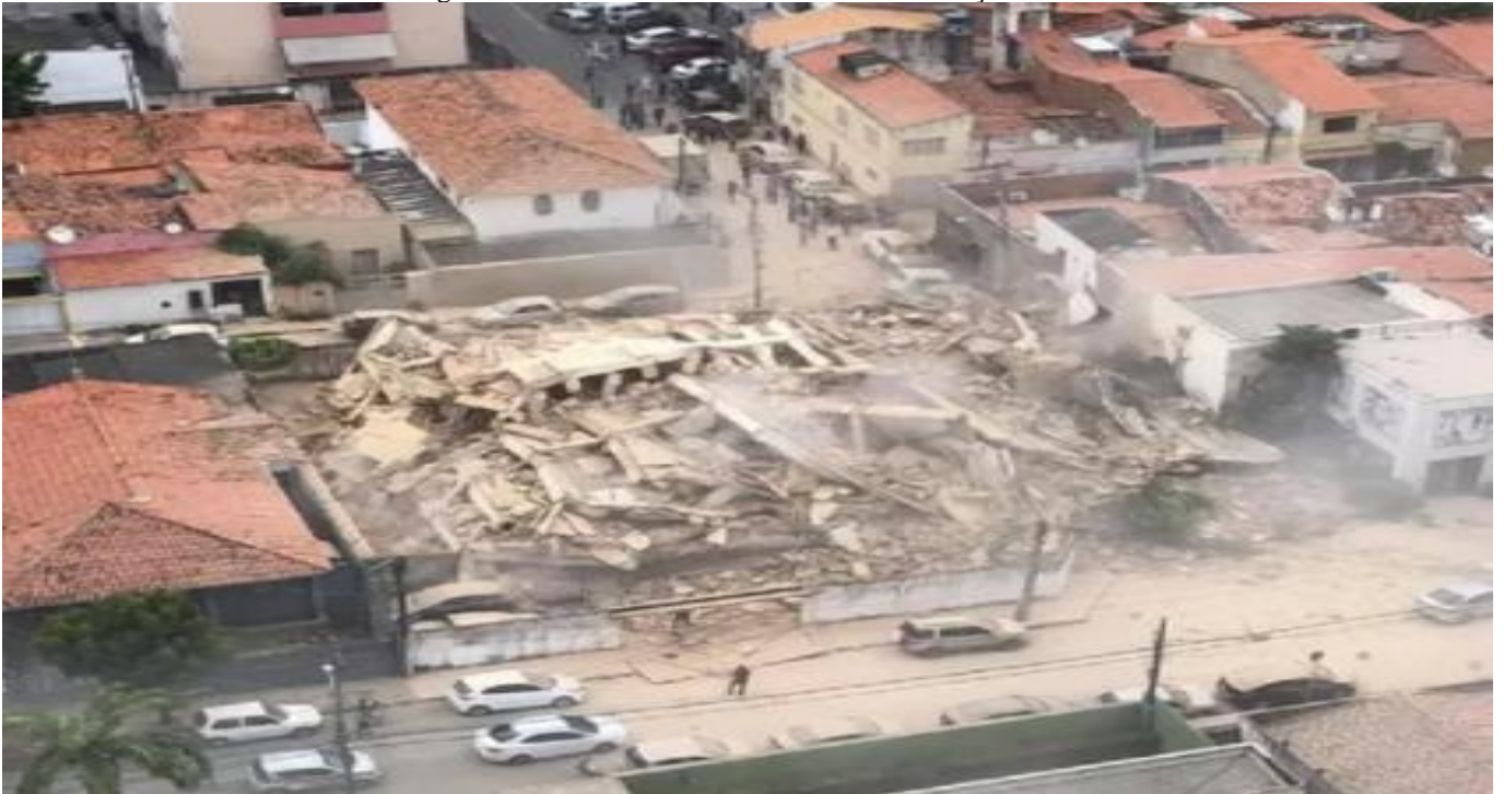
Figura 9: Vista aérea do desabamento da edificação
