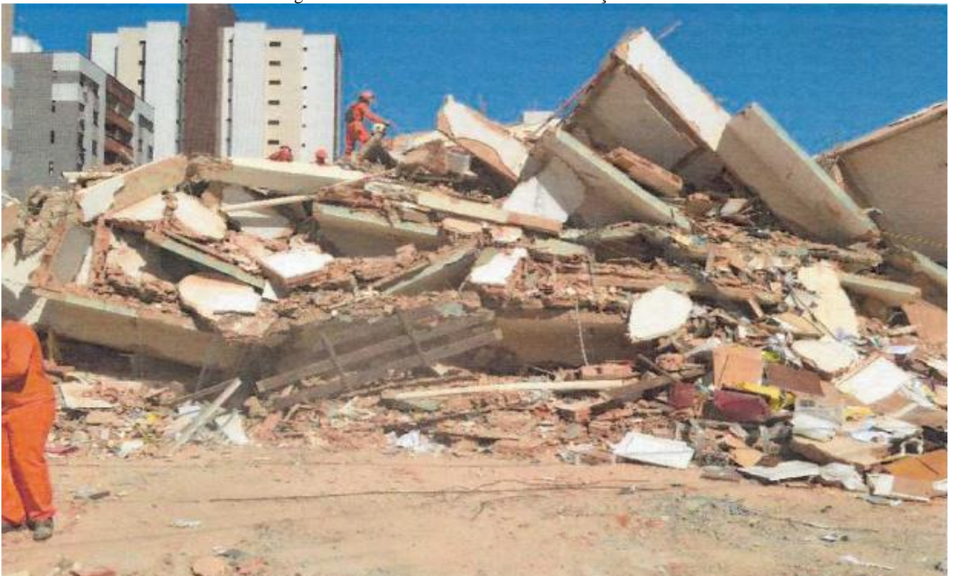
Figura 10: Vista do desabamento da edificação
