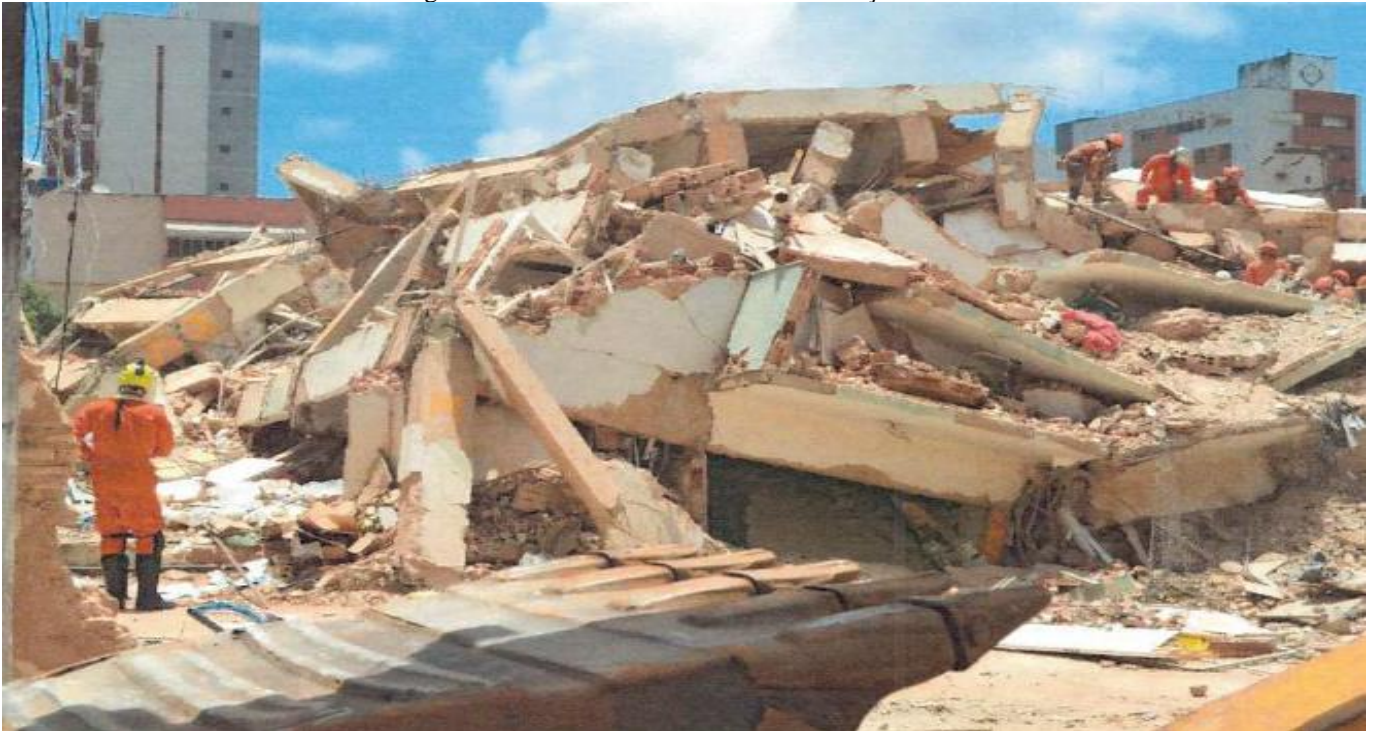
Figura 13: Vista do desabamento da edificação
