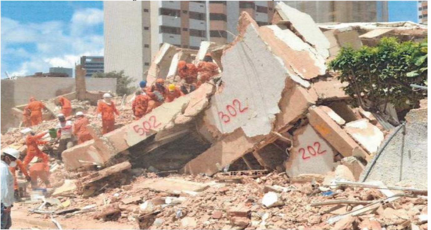
Figura 11: Vista do desabamento da edificação
