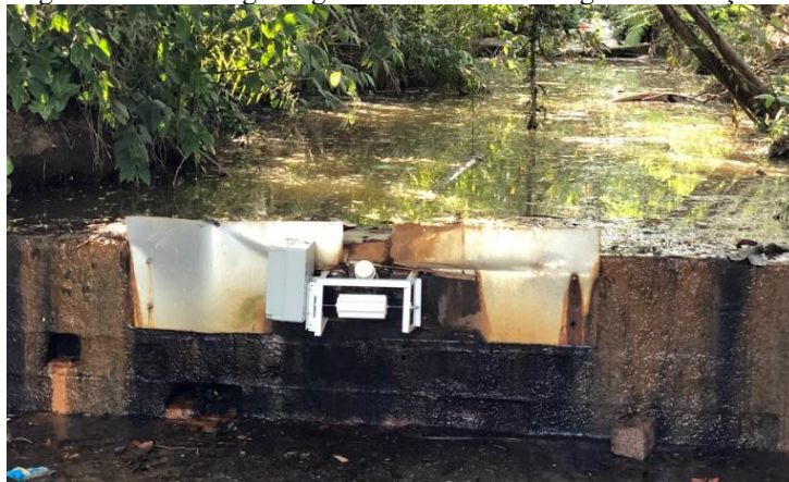
Figura 3 - Roda d'água e gerador fixados a barragem – condição 1.
