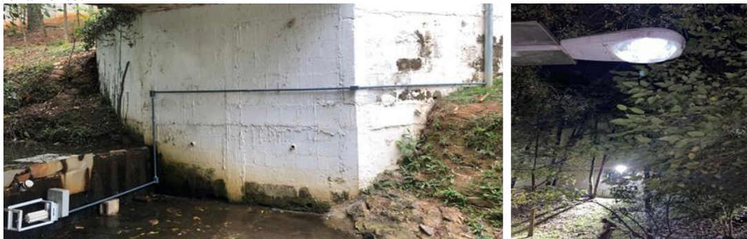
Figura 10 – a) Instalação elétrica e montagem dos eletrodutos do gerador até o poste. b) Luminária com o LED instalado e em funcionamento.
