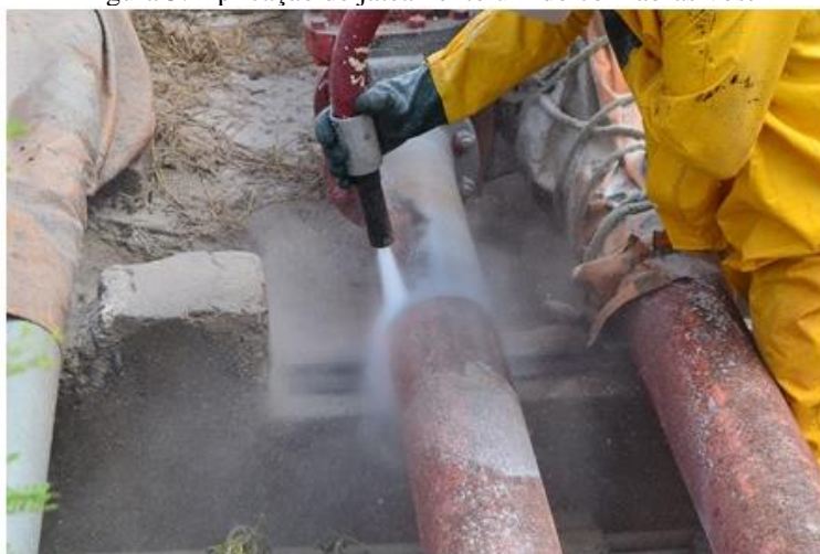
Figura 3: Aplicação de jateamento úmido com abrasivos.
