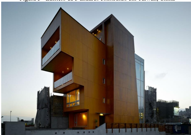
Figura 5– Edifício de 5 andares construído em Taiwan, China
