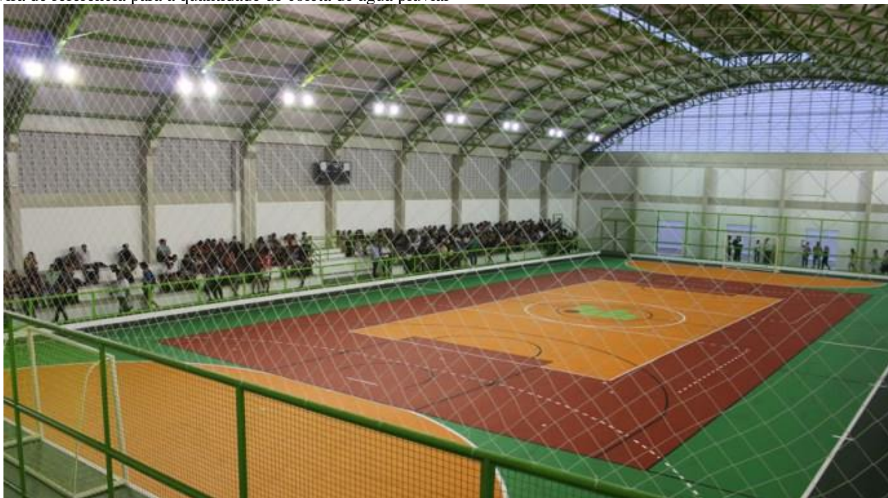
Figura 1 – Ginásio poliesportivo do Instituto Federal de Educação, Ciência e Tecnologia de São Paulo câmpus São Paulo, que servirá de referência para a quantidade de coleta de água pluvial
