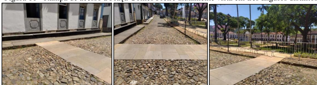
Figura 10 - Rampa de acesso à Praça Gomes Freire atualmente vista em três ângulos distintos
