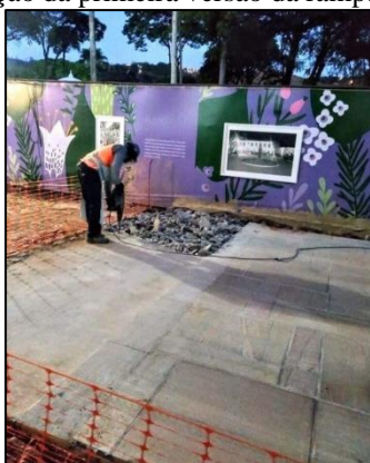
Figura 09 - Remoção da primeira versão da rampa de acesso à Praça
