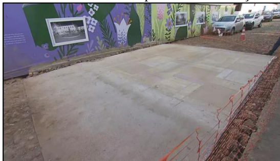
Figura 06 - Primeira versão da rampa de acesso à Praça Gomes Freire
