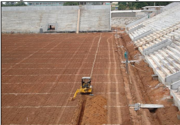
Figura 12. Abertura das trincheiras longitudinais.
