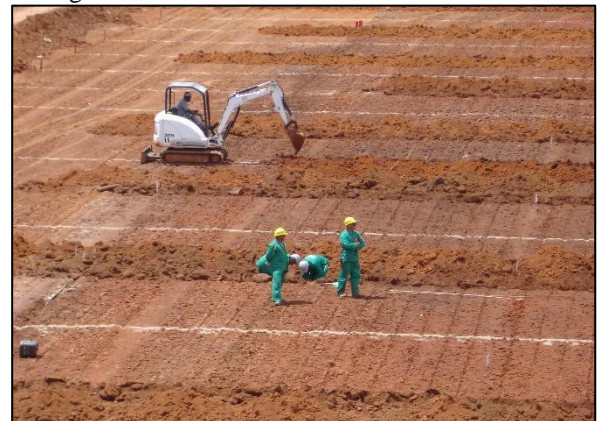
Figura 13. Abertura das trincheiras transversais.
