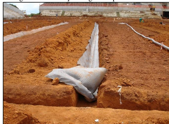
Figura 15. Instalação do geocomposto drenante.
