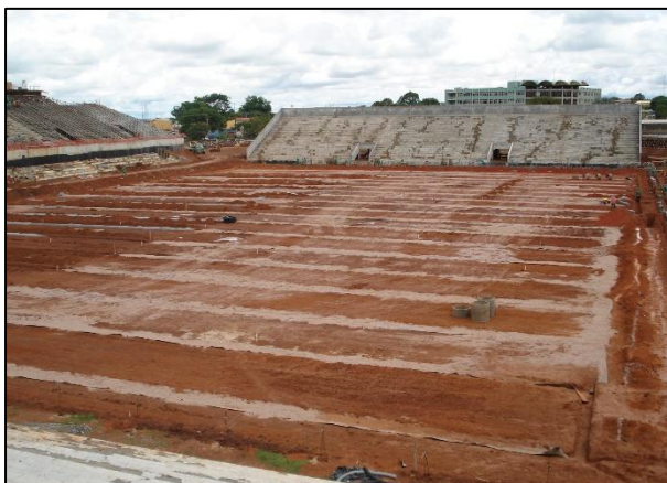
Figura 16. Preenchimento das trincheiras com areia lavada.
