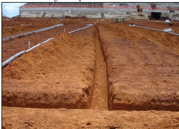
Figura 14. Trincheiras limpas para instalação do geocomposto drenante.
