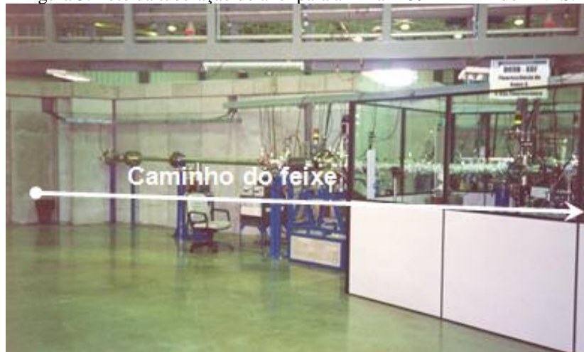
Figura 3: Foto da tubulação do anel para a linha DO9B – XRF do LNLS.
