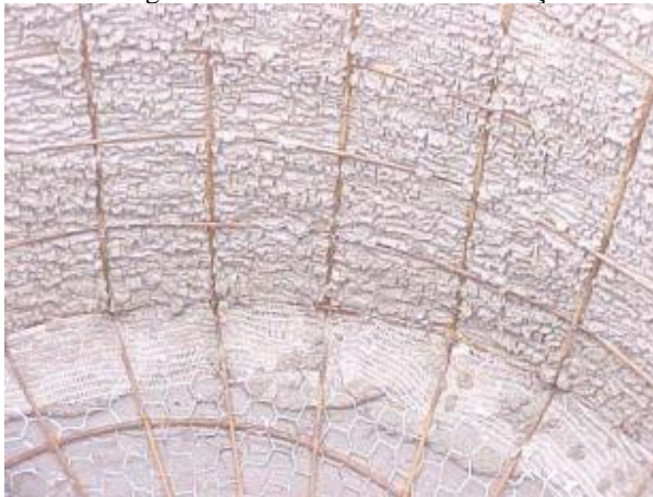
Figura 2: Vista do RAC em construção
